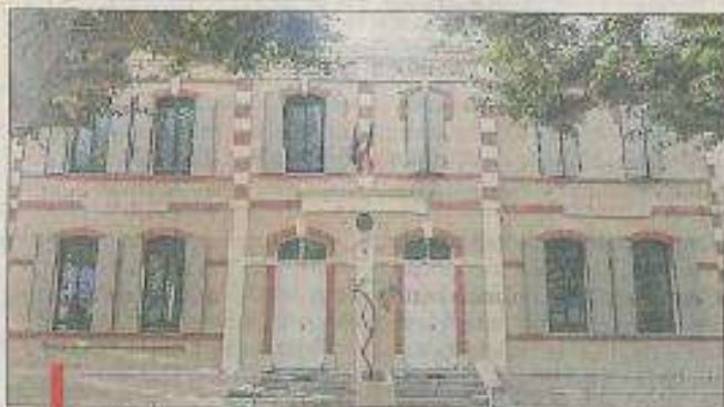
Pendant ces vacances, d'importants travaux pour améliorer les performances énergétiques de l'école vont être conduits. JPH/ATA
